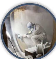
Mantenimiento de tanques
