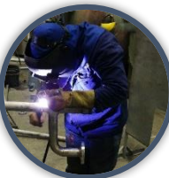
Trabajos en caliente
